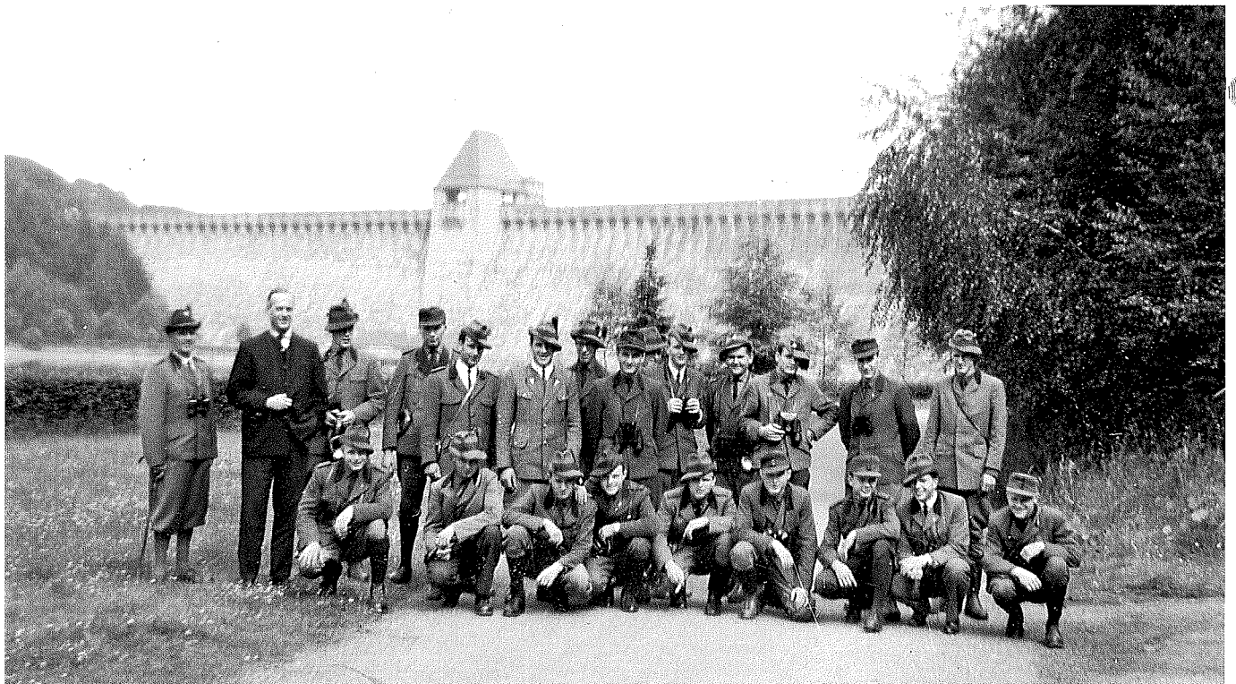
Lehrgang für Lehrlinge und Hilfsjäger Neheim-Hüsten 1963–1965, an der Staumauer der Möhnetalsperre.
