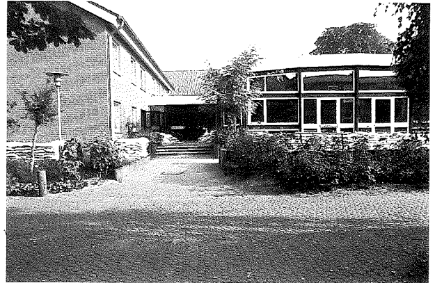
Im linken Gebäude sind die Unterkünfte, rechts der geräumige Speisesaal, davor die Sandsäcke, zur Zeit der Überschwemmung.
